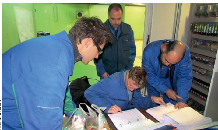
Priprave na prvo sinhronizacijo agregata 3 v novembru.
